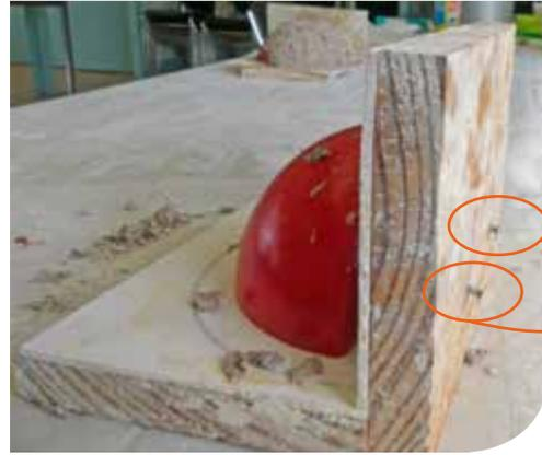
*Pour le nichoir à hirondelle rustique, mettre du mélange à l'arrière du moule en tassant bien avec l'accessoire. Une fois la matière à hauteur des trous, enfoncer les 2 clous dans les interstices et continuer à mettre de la matière.*
