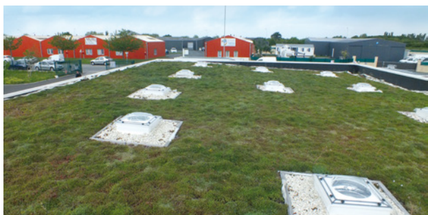
Toiture v g talis e semi-extensive (13 cm de substrat)   association d'insertion Vivractif,   Rochefort
